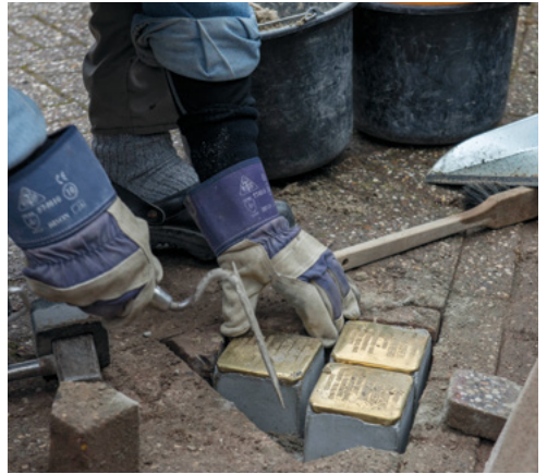
Demmig tijdens plaatsen struikelstenen
